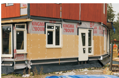
DIFFUTHERM tijdens de bouwphase
